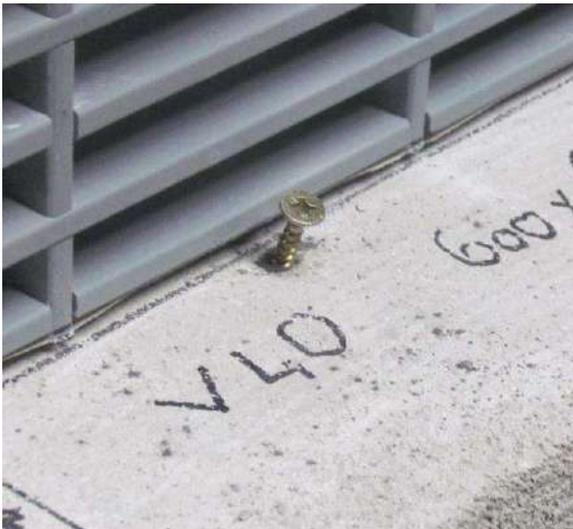
Les grilles de finition ont été installées sur la surface extérieure de l'ouvrage de support et ont été fixées sur chaque coin au moyen de vis de 4.0 x 40 mm et de chevilles en plastique.
